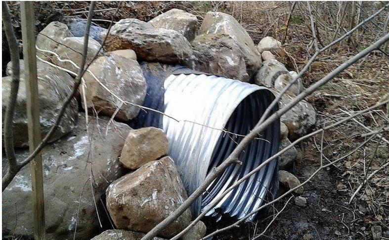
**Remplacement de quatre ponceaux inefficace** par des ponceaux de plus large diamètre pour le drainage des eaux
